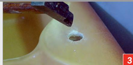
■ Placer l'évier dans la découpe du plan de travail. **Sur le dessus de l'évier**, au niveau du point de repérage, frapper par coup successifs à l'aide du pointeau et du marteau
