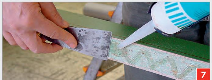
■ Etanchéifier la découpe à l'aide de silicone (non fourni) et d'une spatule.
