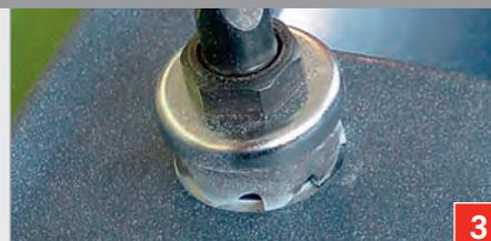
■ **Sur le dessous de l'évier**, percer un trou à l'aide du foret de la scie cloche au niveau de l'amorce conique.
