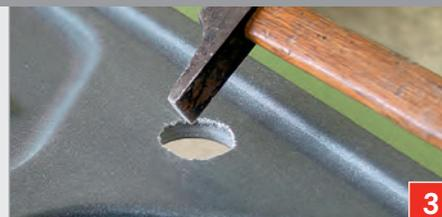
■ Placer l'évier dans la découpe du plan de travail. **Sur le dessus de l'évier**, au niveau de la pastille de repérage, frapper d'un coup sec à l'aide du pointeau et du marteau.
